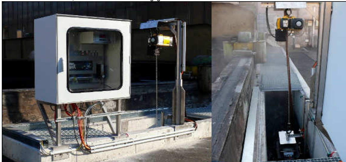
FLUCOMat mit Niveaulift, Schaltschrank und Führungsgestell
